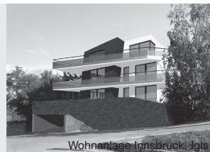
Wohnanlage Innsbruck Jgls
